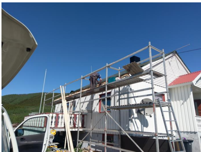
Renovering i Lilandsveien 41
