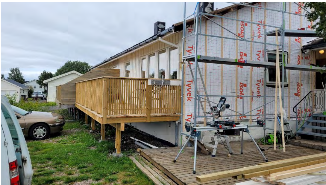
Skifte kledning og bygge altan på Myrbergveien 4 B
